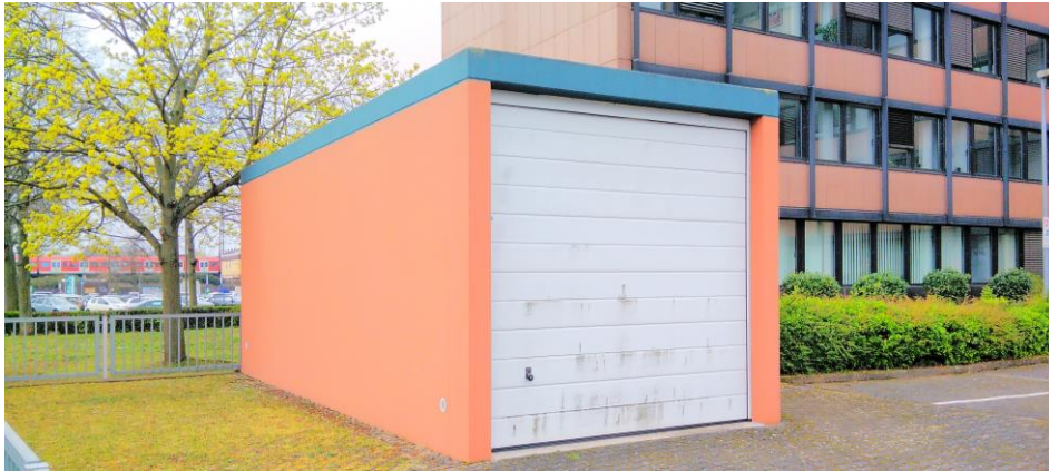
Foto 9.: Die Fertiggarage auf der Ostseite des Eingriffsgebiets nahe der Agentur für Arbeit ist ohne Eignung für Fledermäuse und ohne Befund hinsichtlich etwaiger Gebäudebrüter.
