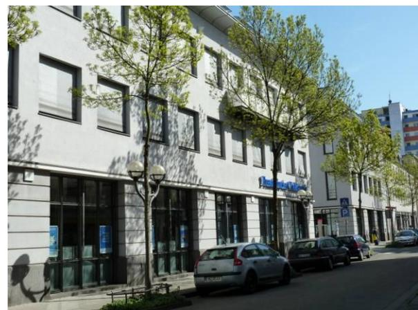
Die durchgehende Fensterfront setzt die Erdgeschosszone deutlich von den Obergeschossen ab, die Schaufensterteilung nimmt jedoch Bezug auf die Fensterachsen in den Obergeschossen.
