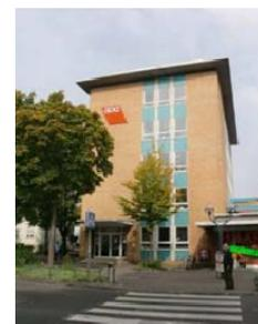
Sichtmauerwerk-Klinker in Kombination mit Betonwerkstein
