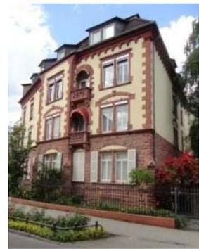
Gestalterisch hochwertige historische Fassaden aus Naturstein bzw. Kombinationen Putzflächen mit Natursteingliederungen sollten nicht durch das Aufbringen einer zusätzlichen Wärmedämmschicht verunstaltet werden, in diesem Fall sollte der Einsatz einer Innendämmung geprüft werden.
