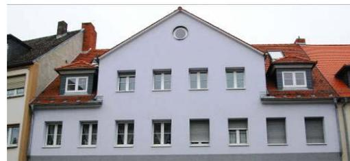
Dachaufbauten sollten als untergeordnete Bauteile erscheinen. Das Hochziehen der Fassade mit Balkonen im Nebenstehenden Beispiel wirkt unproportioniert.
