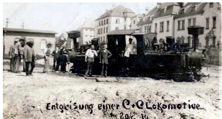
Eine Doppel-Lokomotive ist unmittelbar hinter der Hessen-Homburg-Kaserne auf dem Gelände der Feldbahn-Werkstatt entgleist. Die Gebäude von rechts nach links: Wirtschafts-haus II (heute Staatliches Schulamt), Mannschaftshaus III (heute Technisches Rathaus), Garnisons-Gefängnis (zuletzt Hutier-Kaserne, Übergangswohnheim der US-Armee).
