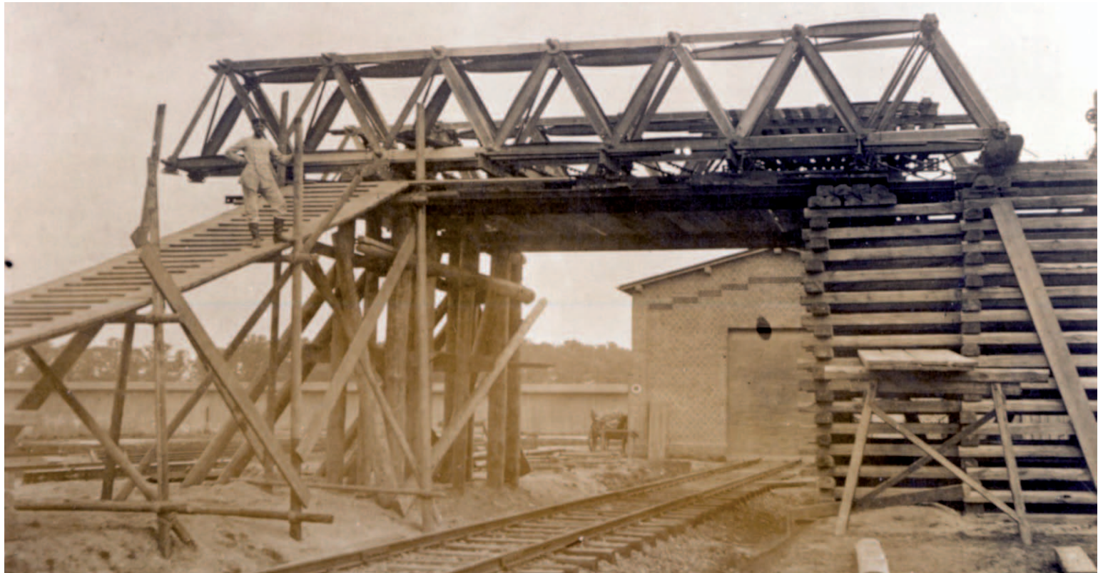
Vor dem Lokschuppen des Kriegsdepots wurde als Übung ein Element der Lübecke-Kriegsbrücke von Pionieren erbaut. Hinter dem Lokschuppen verläuft die Ruhrstraße.
