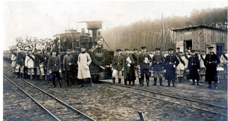
Am Bahnhof „Brückengrube“ steht ein Feldbahnzug, bestehend aus einer Brigade-Lokomotive mit angehängtem Tender und Feldbahnwagen fertig zur Abfahrt in Richtung Wasser-Übungsplatz Kinzig. Die Brückengrube befindet sich direkt hinter der Hutier-Kaserne.
