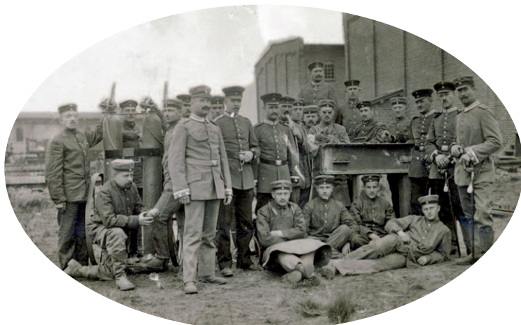
Ausbildung der Schmiede und Schlosser mit Schweißgerät vor den beiden großen, über 100 m langen Feldgeräteschuppen (zuletzt Naxos-Union) im Eisenbahn-Neben-Ersatz-Park.
