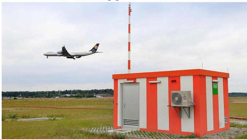
Abbildung 67: Eine GBAS-Bodenstation sendet dem Flugzeug seine genaue Position<sup>343</sup> © Fraport AG
